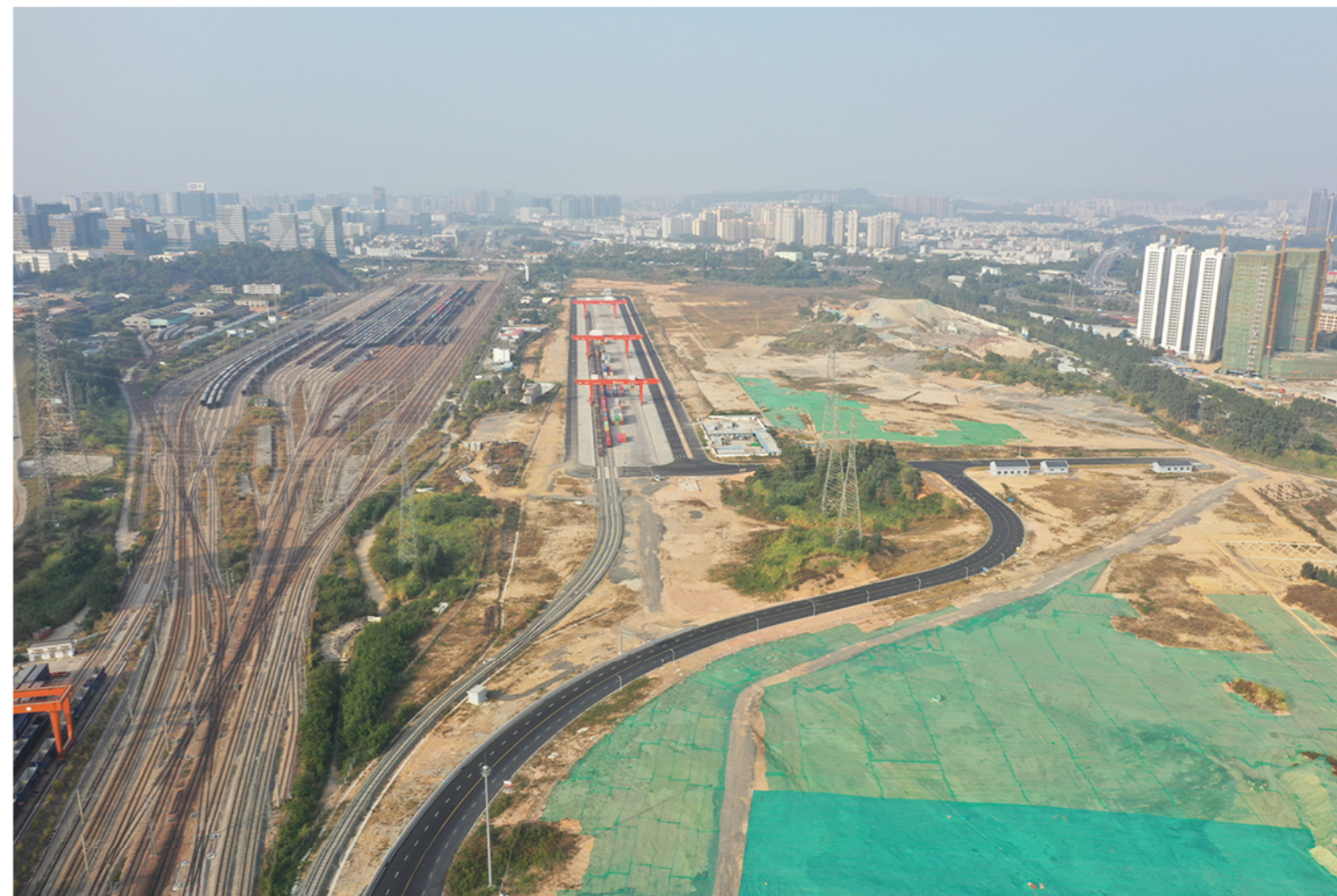
▲平湖南国家物流枢纽施工现场。
