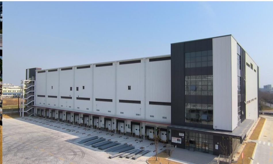
南京江宁项目（冷仓面积约 3.3万m 2 ） 2024年12月竣工验收，并已于2025年2月投入运营
