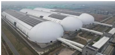
靖江港棚厂已覆盖光伏
