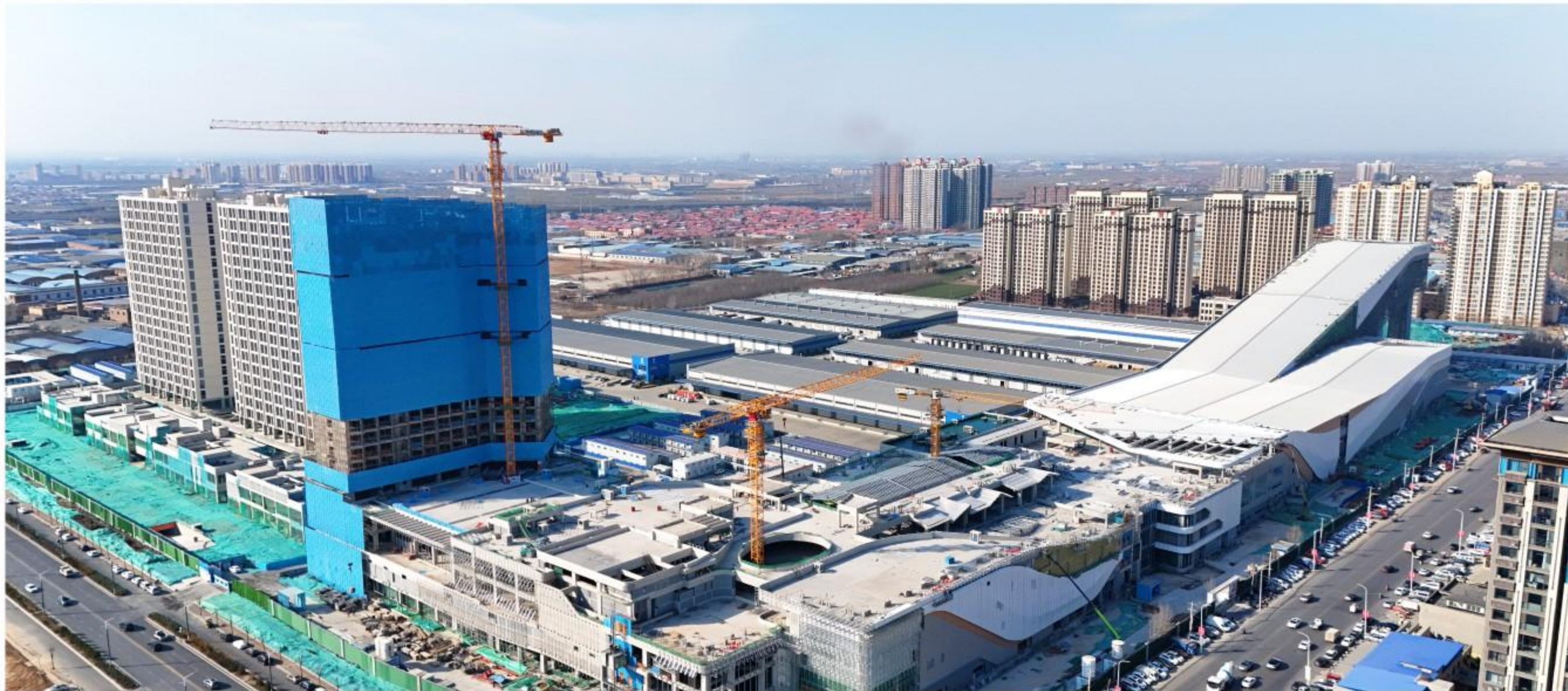
深国际商置 | 石家庄·真悦天地（在建实景图）
