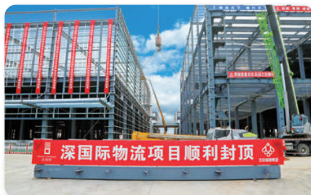
深國際京西南綜合物流樞紐（一期）智慧物流中心
