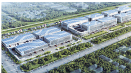
19 深國際京西南綜合物流樞紐 (一期)智慧物流中心#
