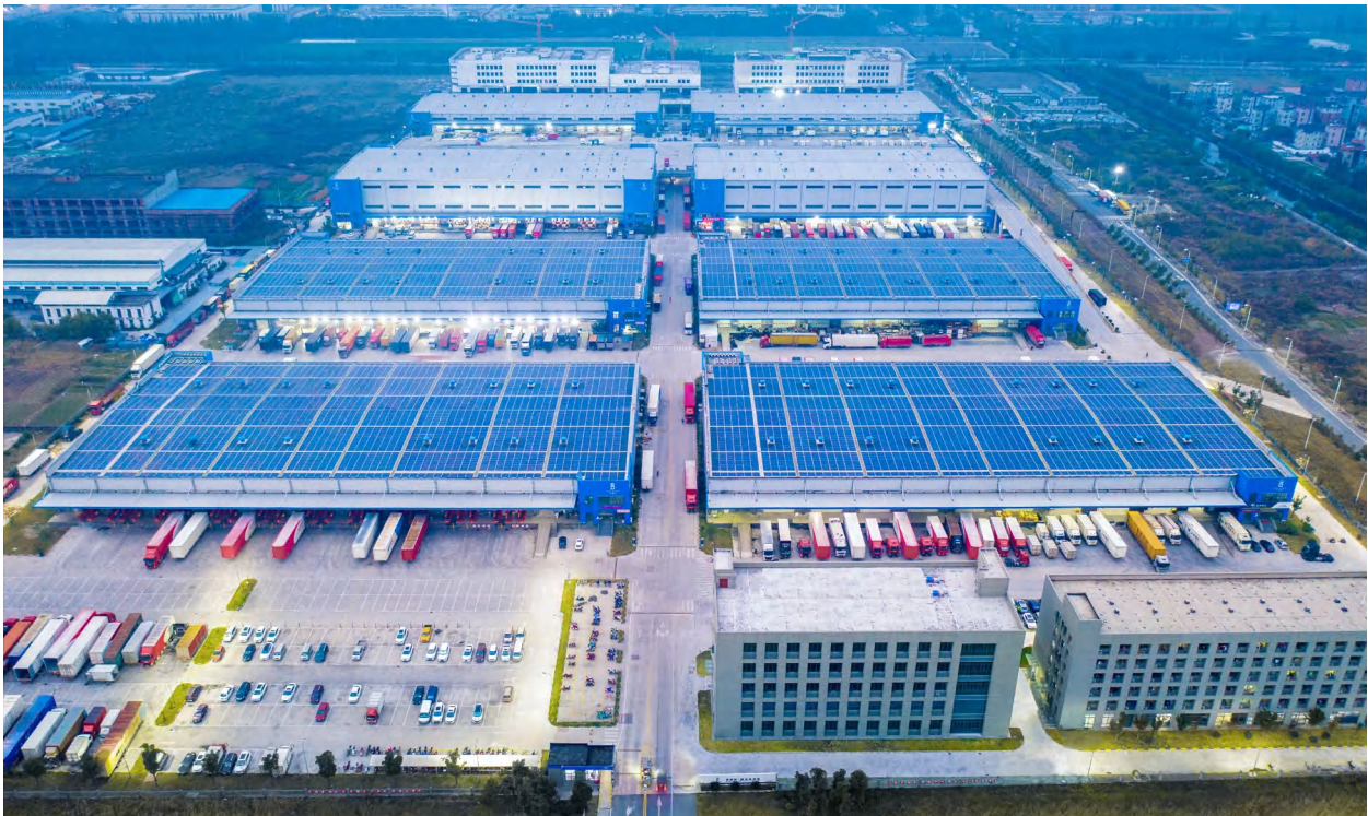
深国际物流港 | 杭州 · 项目屋顶光伏
