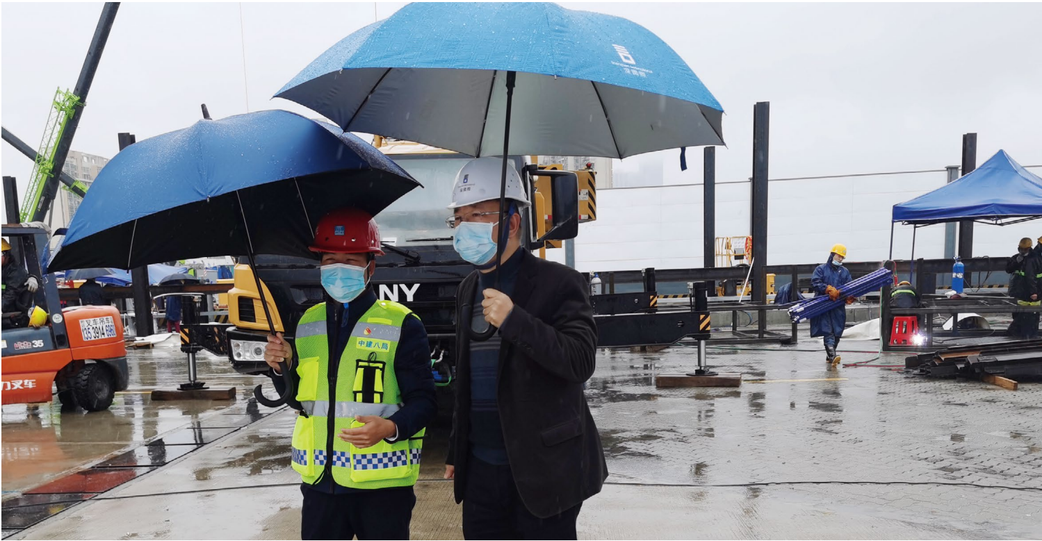
2022 年 2 月，深国际开展龙华区深港跨境运输集中接驳站建设安全检查
