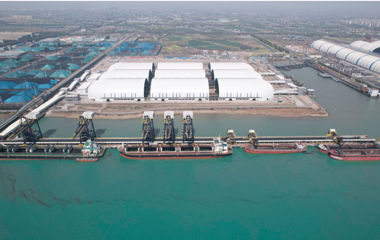
深国际港口 | 江苏靖江港封闭大棚
