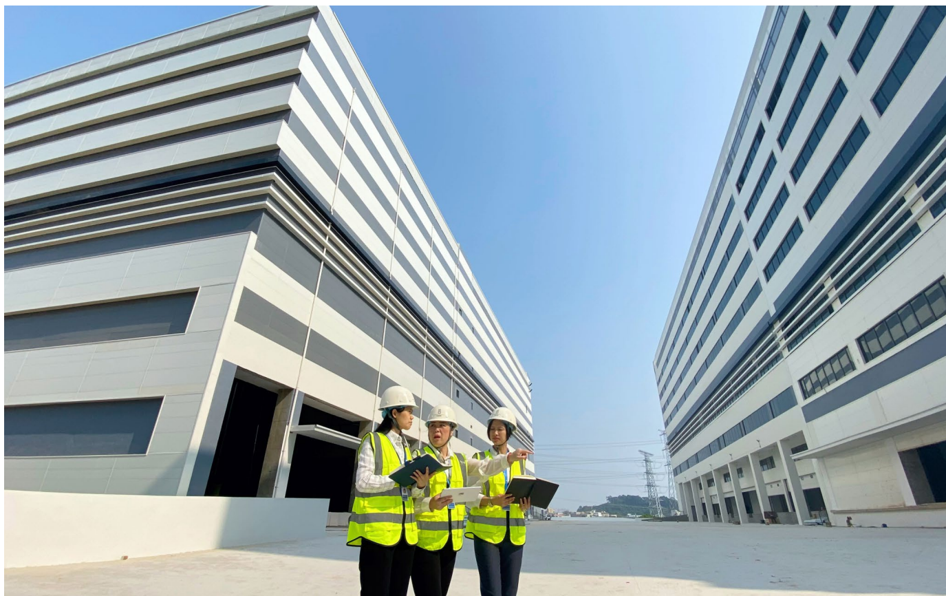
深国际智慧物流港 | 深圳·黎光项目
