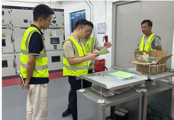
台风前排查抢修电力设备
